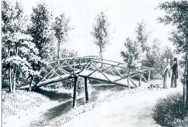
Nr. 20 – brug op het landgoed
