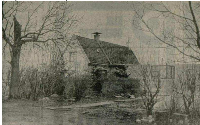
De woning van de heer Jan Verkerk bij Minnertsga zou een grote uitbreiding ondergaan. Op de foto is daar rechts een stukje van zichtbaar. Het bouwterrein ligt er inmiddels, nu de aannemer zijn werkzaamheden er heeft gestaakt, verlaten bij.
